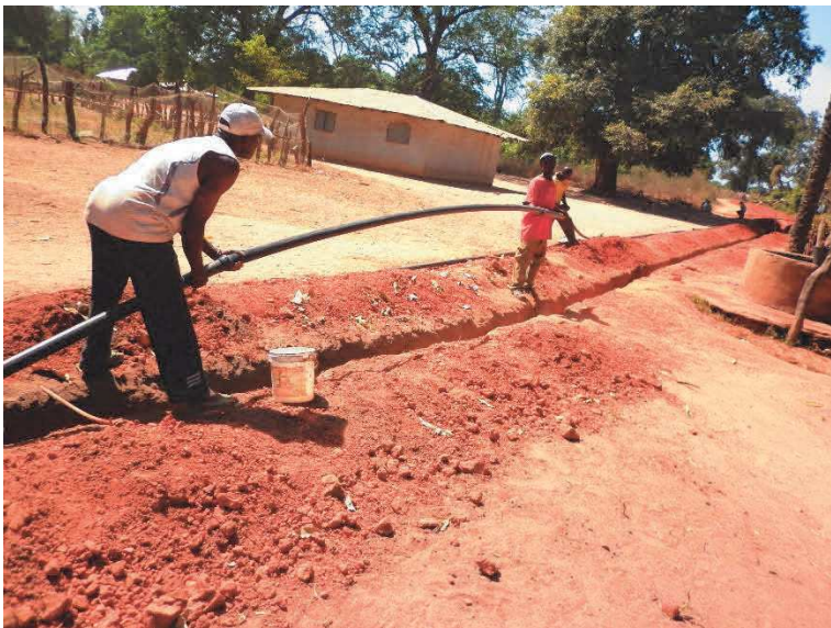
# cantiere e lavori
